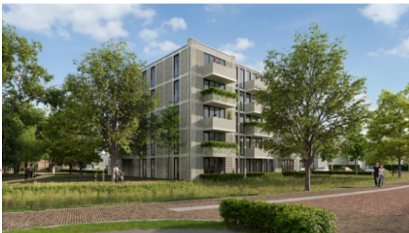
Schooneng, Voorthuizen – 46 appartementen
