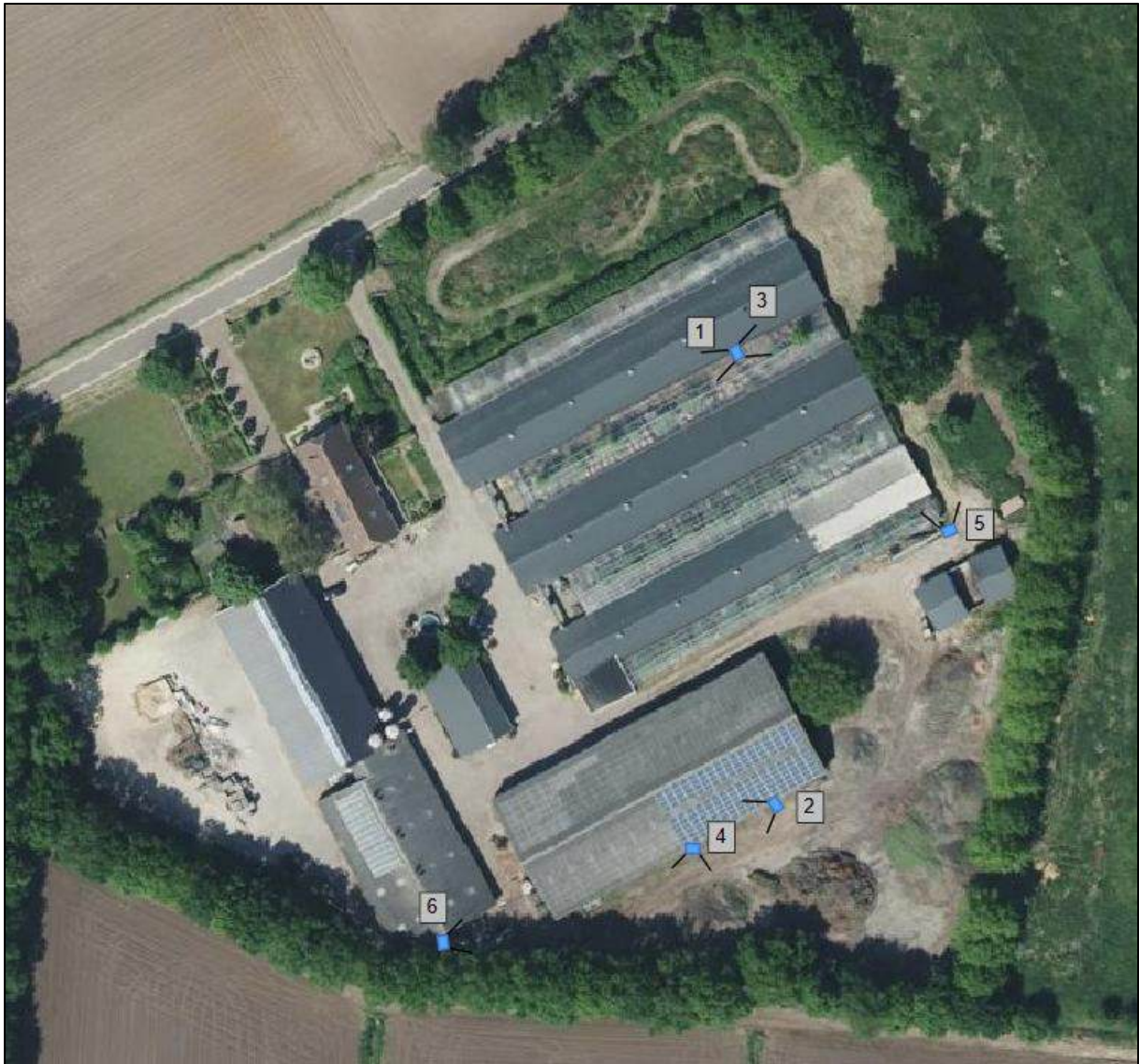
Overzicht planlocatie met locatie geplaatste camera's
