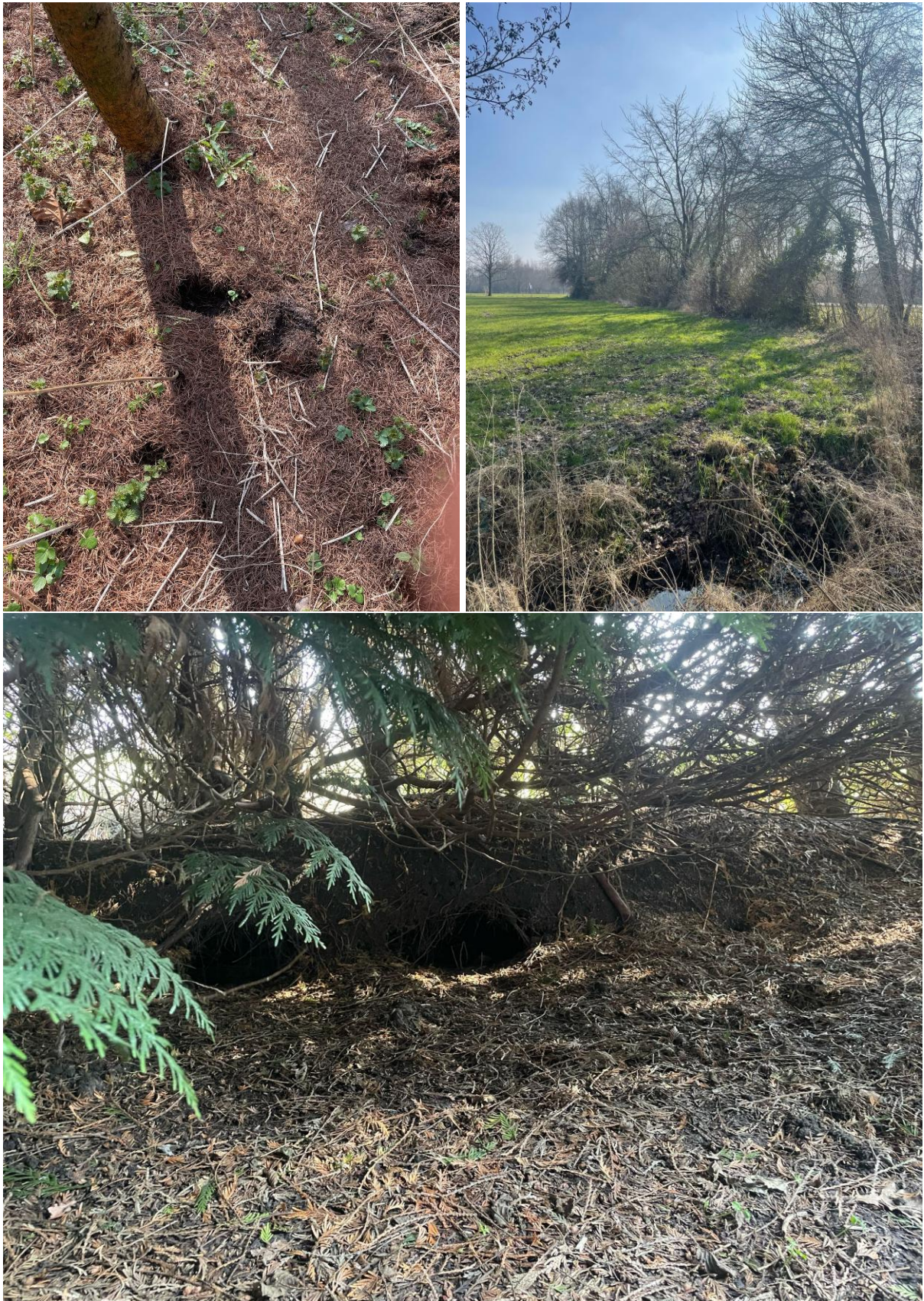
Figuur 3: Linksboven aangetroffen graafsporen. Rechtsboven een aangetroffen wissel richting de omliggende houtwallen. Onderin de gevonden opening vermoedelijk veroorzaakt door een storm (foto's: Laneco, 2025).
