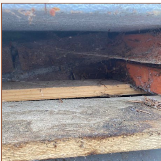
Afbeelding 6: Ruimte onder het dakbeschot van damwandplaten aan de buitenkant van de gevel. Ook hier nergens nesten of nestresten.
