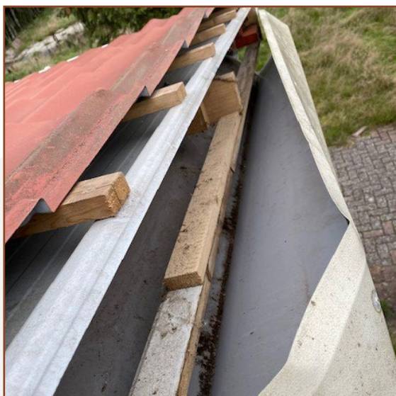
Afbeelding 4: De dakconstructie met verwijderde daklijst.
