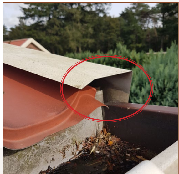
Afbeelding 3: De dakconstructie is voor vogels alleen toegankelijk ter hoogte van de hoeken van het dak (rode cirkel).
