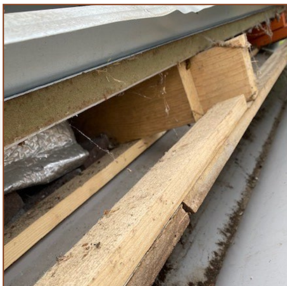
Afbeelding 5: De ruimte onder de damwandplaat. Deze is grotendeels opgevuld met isolatiemateriaal en wordt of werd niet door vogels gebruikt.
