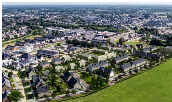
De Burgt, Lanen-Oost, 226 woningen. Foto: BK
