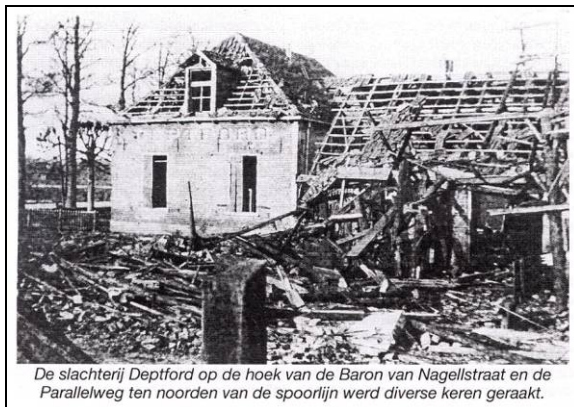
Figuur 2: Verwoeste slachterij in het onderzoeksgebied Barneveld-Noord Station.
